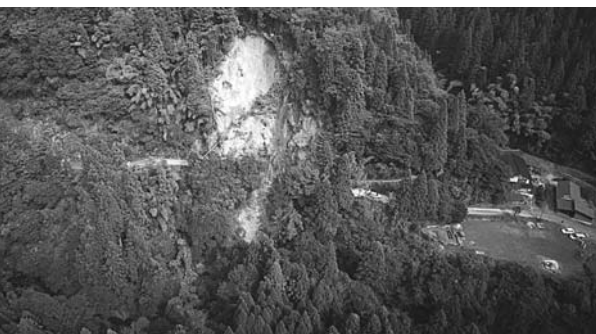
全面通行止となっている湯谷上山線
